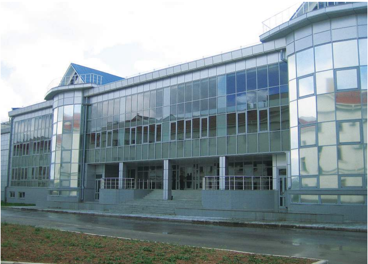
Спорткомплекс с плавательным бассейном в городе Севастополь Система Текно Фасад 50
