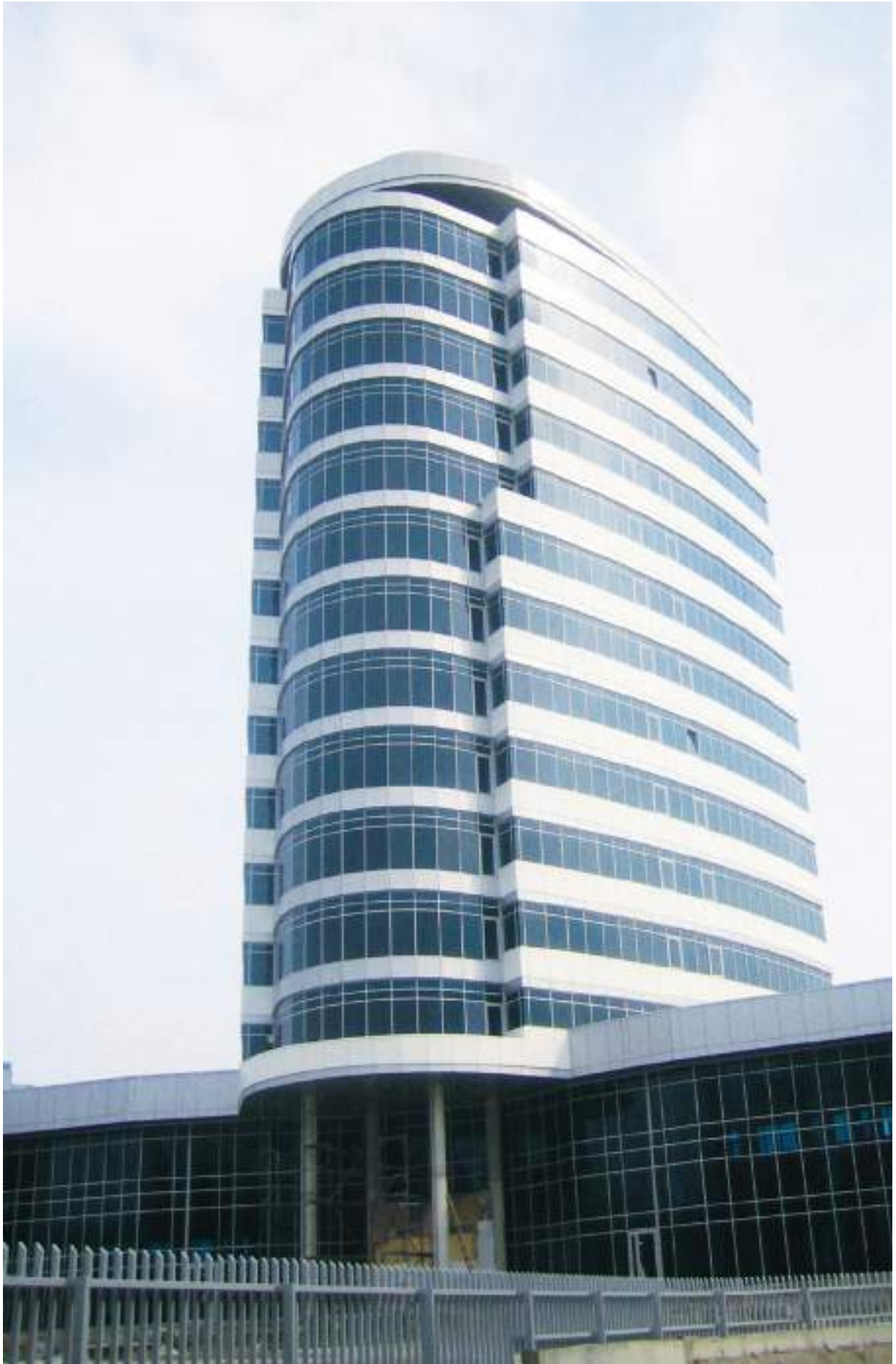
Здание «Киевстар Дж.Эс.Эм.» в городе Днепропетровск Система Текно Фасад 50
